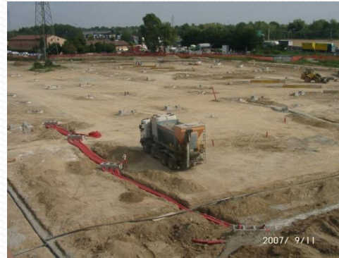
Parcheggio Autoarticolati Brescia Centro
